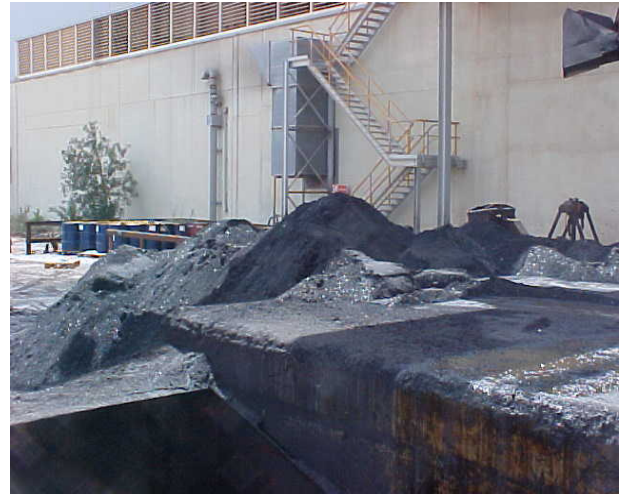
صورة (7) عملية نزع الطوب الحراري
