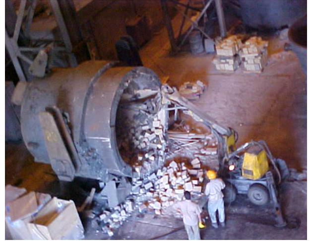
صورة (7) عملية نزع الطوب الحراري
